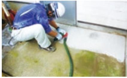
研磨機が使えない狭い場所は、手作業でコンクリートの表面を削る。
