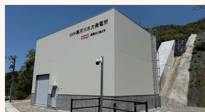
▲COOP黒河川水力発電所の外観 （福井県民生協）
