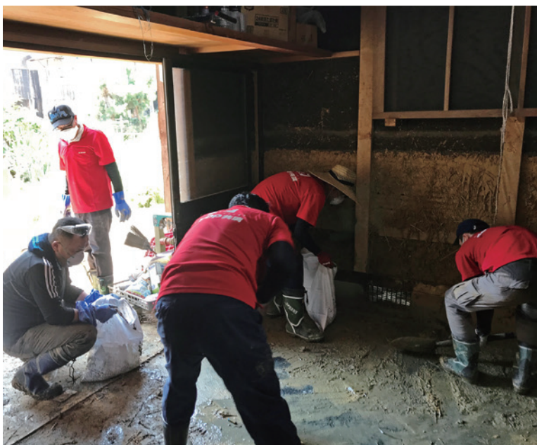
家屋からの泥のかき出しの様子。
