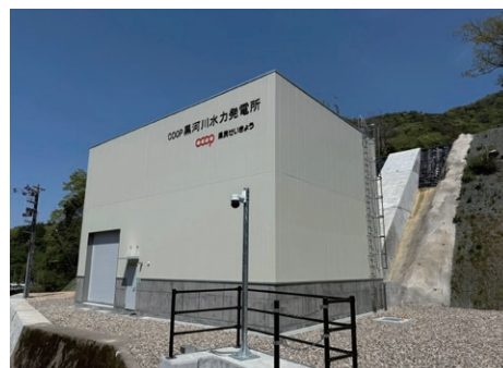
COOP黒河川水力発電所の外観
