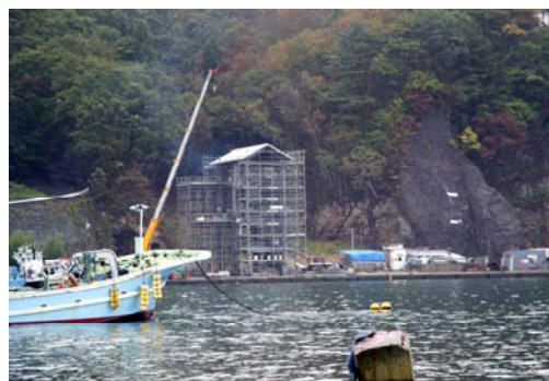
建設中の田老町漁協製氷工場。
