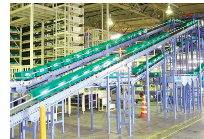
物流施設の整備・共同利用で 合理化を進めています
