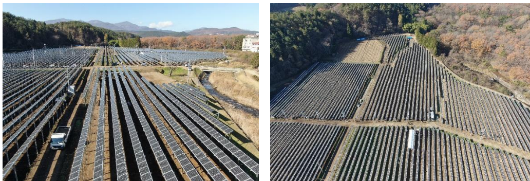
国内最大規模となる営農型発電設備「二本松ソーラーシェアリング」
