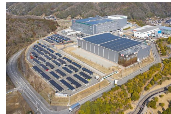
尾道ドライ流通センター・尾道冷凍流通センターの社員駐車場に設置された太陽光発電設備
