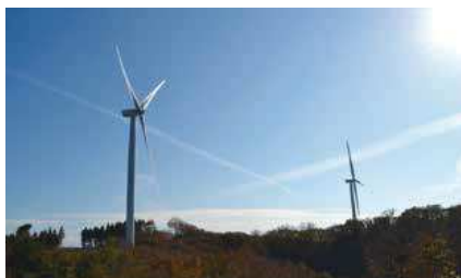
▲コープ東北グリーンエネルギー(株)のコープ東北羽川風力発電所
