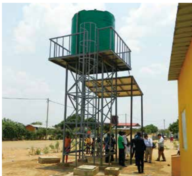
ユニセフの支援で設置されたアンゴラ共和国の小学校の給水施設▶
