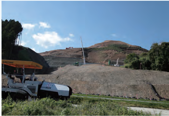
岩手県陸前高田市今泉地区での高台造成の様子。ここでは2016年5月から住宅の建築が可能となる見込み。
