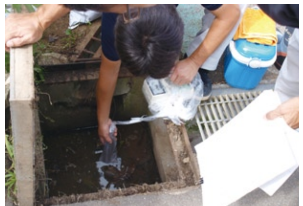
排水槽は極端に高い放射線量が検出される場所。
