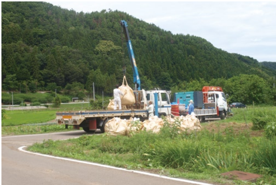
除去した土は1トンバッグに集められ、トラックで運搬される。
