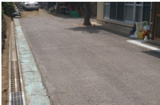
住宅のアスファルト部分の除染は伊達市が別途契約した業者が実施。縦についている筋はアスファルトを削り取った際にできたもの。
