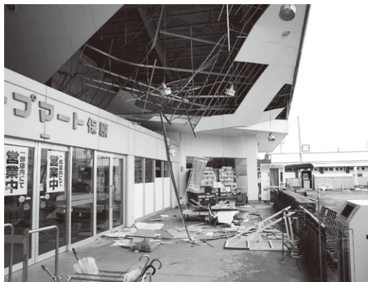
コープmart保原では、軒下の天井が落下。コープふくしまで最も大きな被害を受けた店舗のひとつ。
