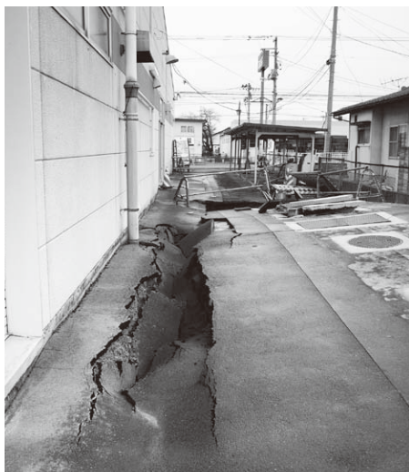
コープmart笹谷では店舗裏のアスファルトが陥没した。
