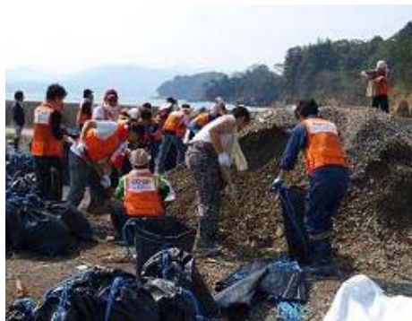
頑丈な土のう袋に、砂利を60kgずつ詰めていく。
