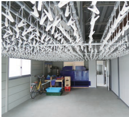
同じく田老漁港すぐそばに建設された昆布の乾燥施設。
