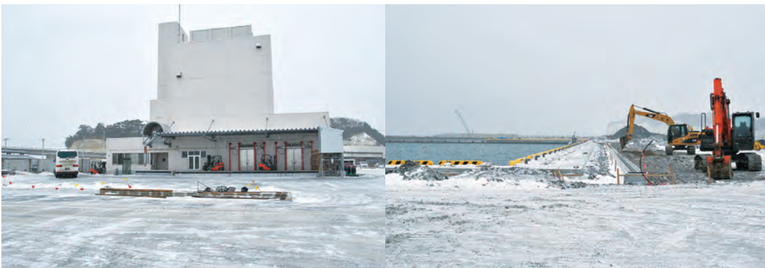
新しく建てられた製氷工場。
