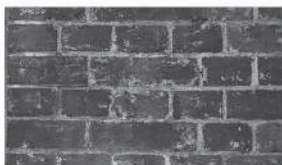
イギリス式とはレンガの長い面と短い面を交互に積み重ねる方法
