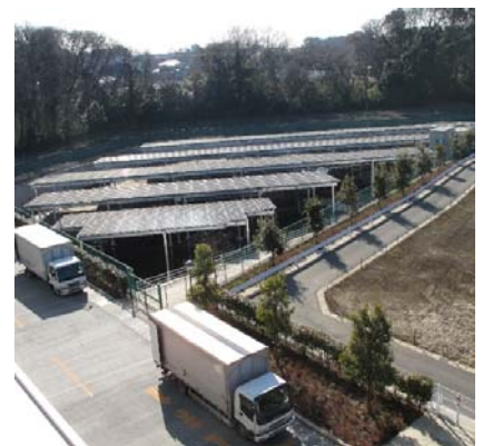
野田流通センター（千葉県野田市）の敷地に設置している太陽光発電パネル
