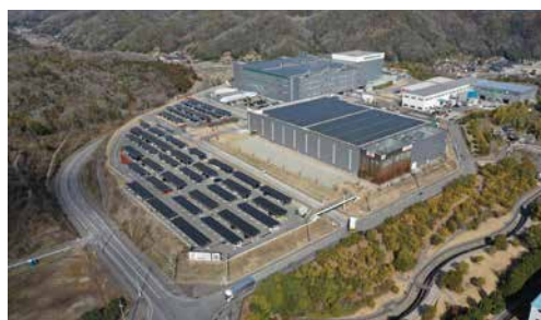
画像提供：日本生協連（カーポートタイプ太陽光発電）
